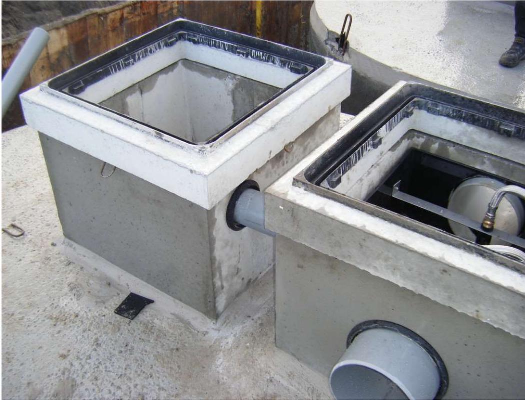
Zwei Betonzisternen mit 20.000 l mit zwei Trident 1650 Filter und einem IRM 10 Wassermanager. Das Regenwasser wird verwendet für die Toilettenspülung und zur Befüllung der Löschwagen.
